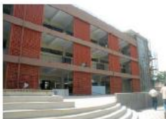
Sustitución pisos Primer Nivel, Edificio Estudios Generales
