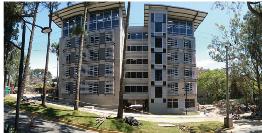
Anexo ECCI 3630 m 2 Constructora LICSA Inspección OEPI
