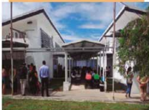
Foto No 3. Módulo Nuevo de Aulas del Recinto de Guápiles
