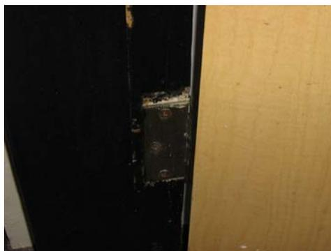
Hay problemas en las puertas de las aulas y partes metálicas que muestran corrosión.
