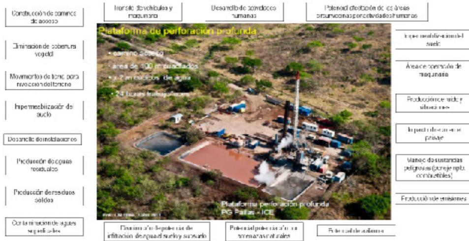
Resumen de impactos ambientales que podría producir un sitio de perforación geotérmica. La foto corresponde con una plataforma de perforación del ICE en el Proyecto Pailas.
